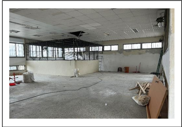
木板隔間全拆除，鐵架準備移除中
