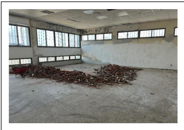
水泥牆面打除
