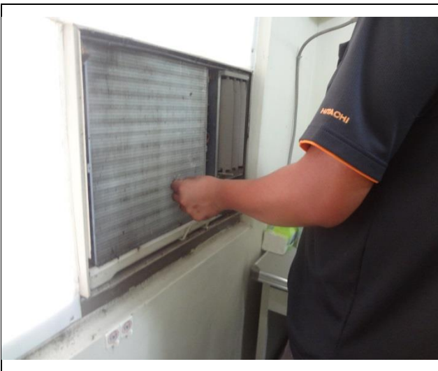
更換冷氣控制面板
