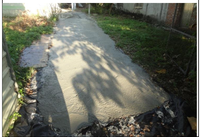
廠商鋪設水泥 2
