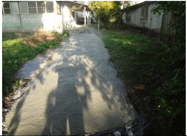
廠商鋪設水泥 1
