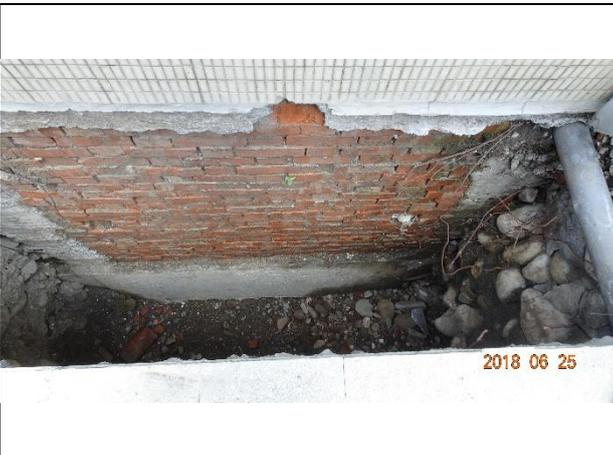
崇德樓鋼構阻尼器基礎開挖無地梁情形。
