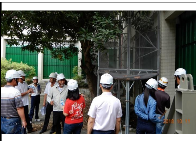
工程施作項目查核
