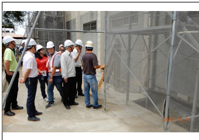
工程施作項目查核
