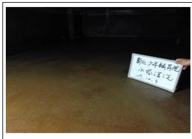
淑德樓水塔清洗後
