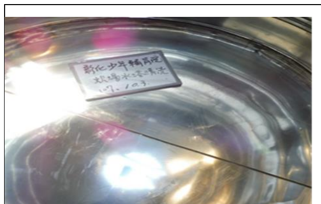
炊場水塔清洗後
