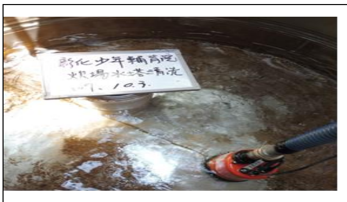
炊場水塔清洗前
