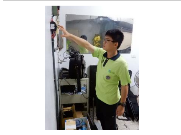
關閉電源(安全防護)
