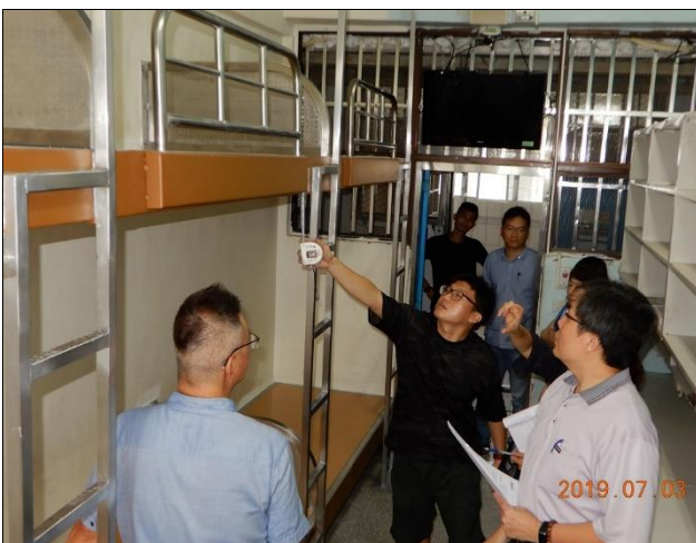
A棟安裝完成驗收中
