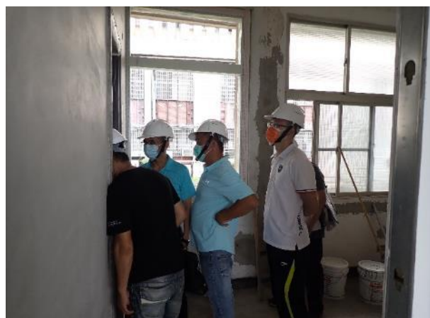
堪查行政大樓 2 樓廁所施工
