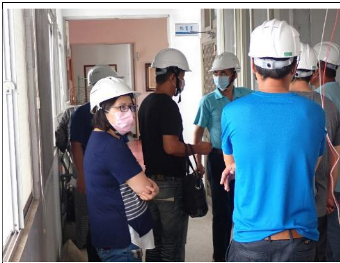
堪查行政大樓 2 樓副校長室施工
