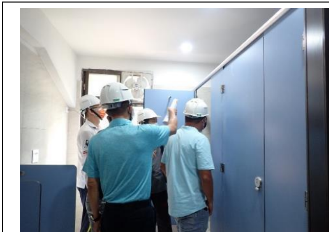
堪查進德樓 2 樓廁所施工
