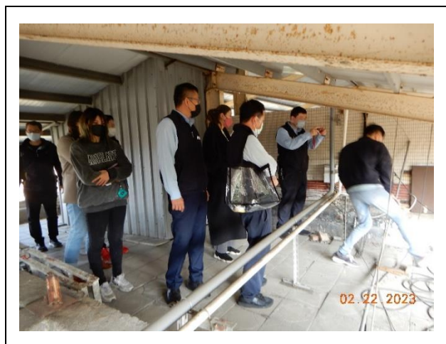
至崇德樓屋頂勘查漏水原因
