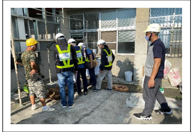
實地訪查施作情形
