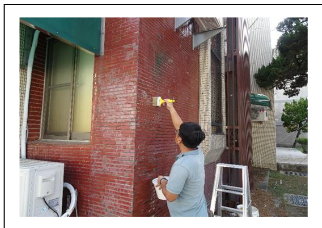
牆壁補強防水漆
