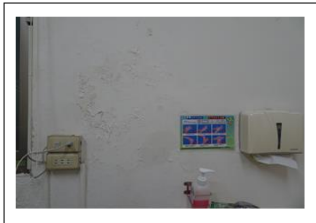
診間壁癌剝落及滲液情形
