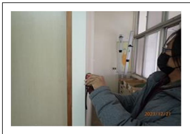
抽驗淑德樓辦公室施作情形
