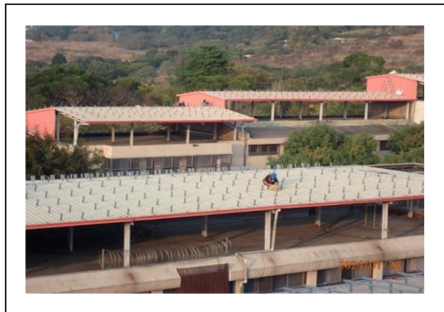
屋頂施工情形
