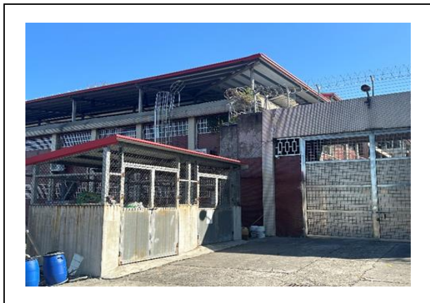
施工及維修通樓梯設置情形
