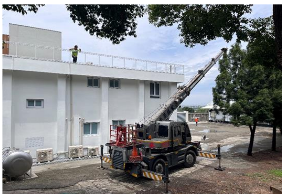
廠商吊掛施工材料
