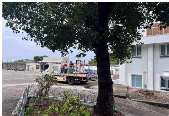
廠商吊掛施工材料
