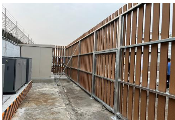
高低壓配電設備施作
