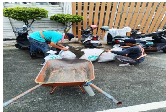
土石沙包整備包裝中
