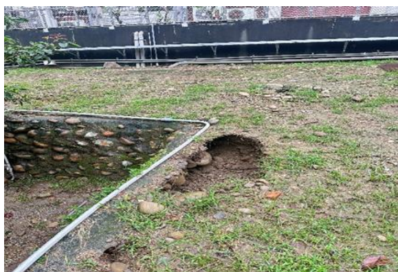
行政大樓掏空現況
