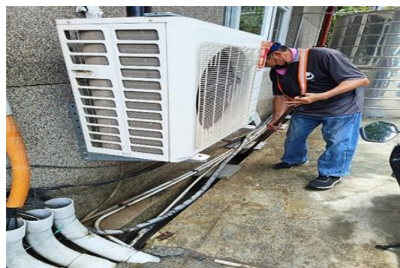
排水溝清理中
