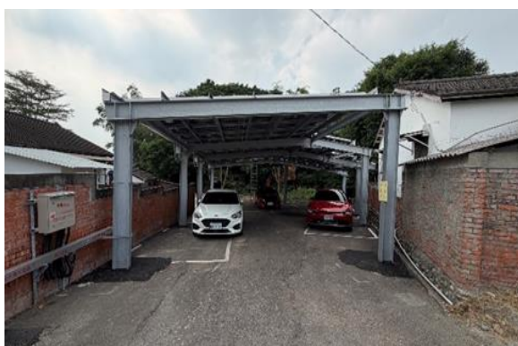
多處汽車停車場
