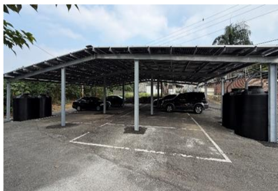
汽車停車場施做後現況
