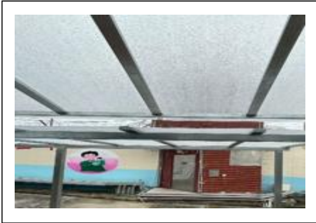
風雨走廊完工及點收
