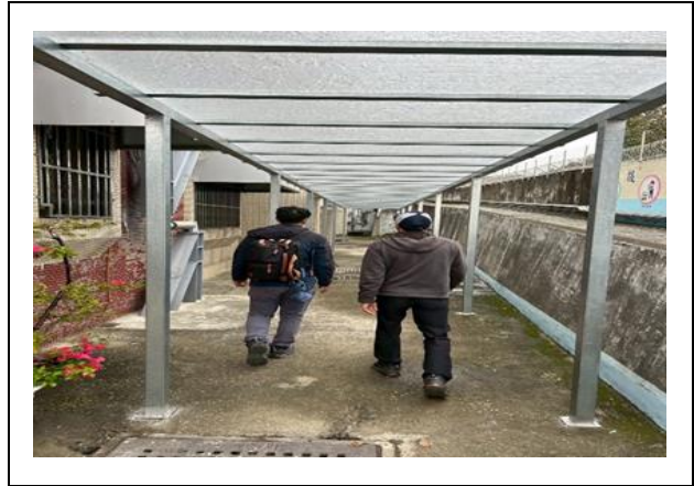
風雨走廊完工及點收
